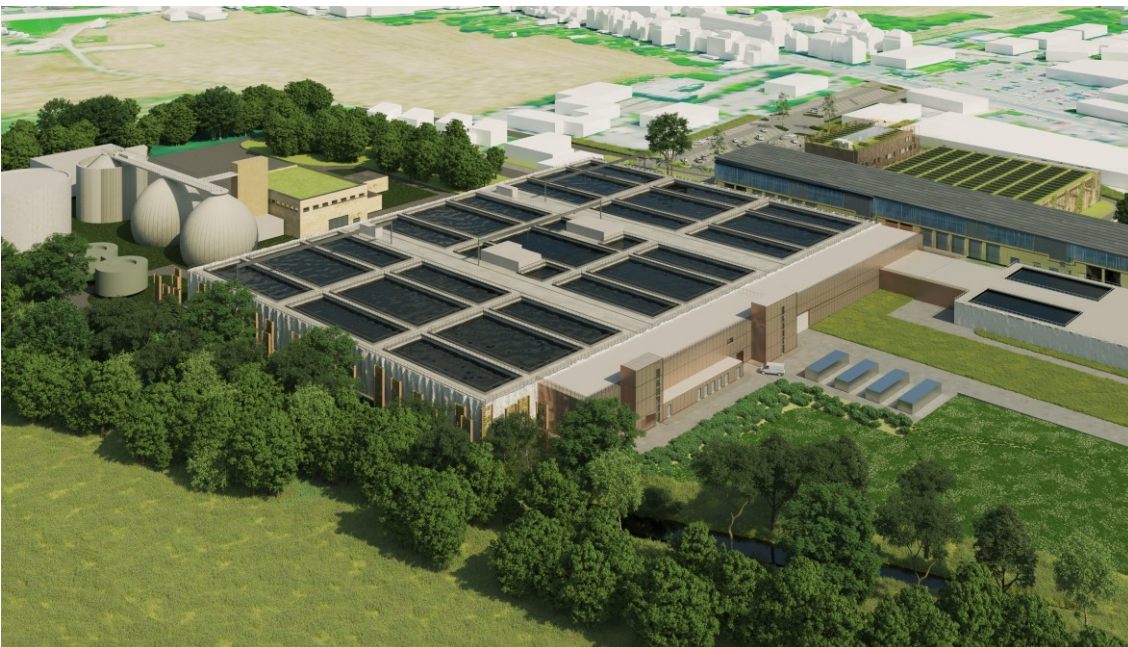
Vue aérienne générale
