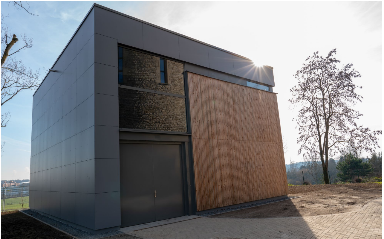
Station de pompage et de traitement d'eau « Tubishaff » © Ville de Luxembourg
