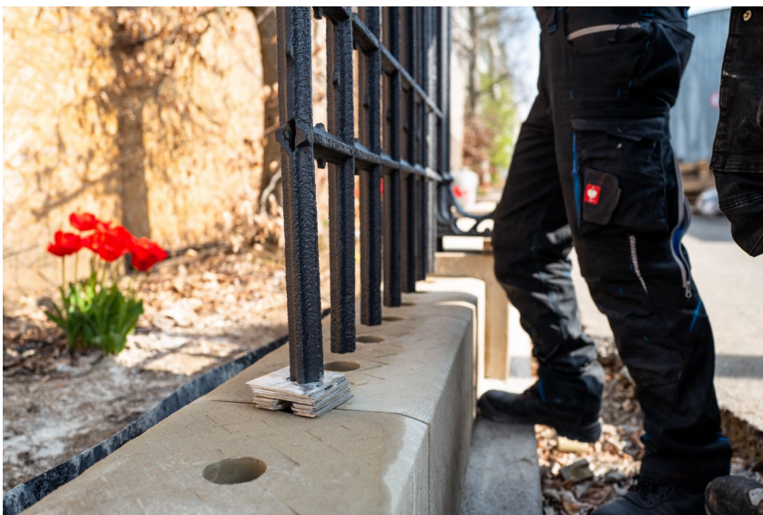
Mise en place des éléments de clôture © Ville de Luxembourg – Service Communication et relations publiques, Tom Jungbluth
