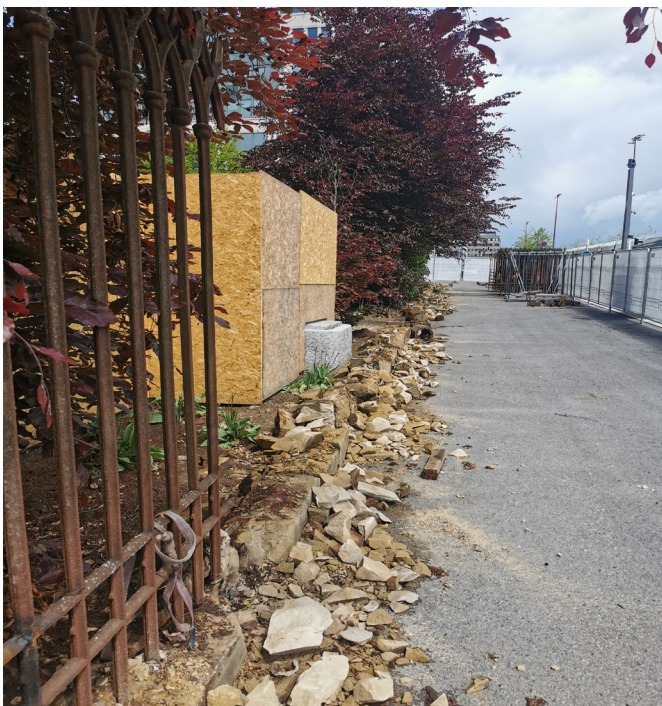
Démolition de la fondation © Ville de Luxembourg – Service Bâtiments
