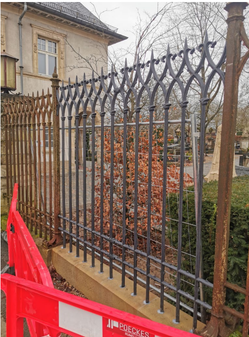
Échantillon restauré lors de la phase préparatoire © Ville de Luxembourg – Service Bâtiments
