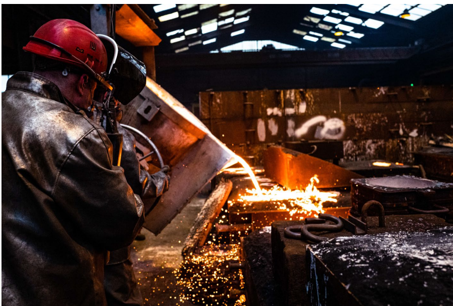
Coulage des nouveaux éléments de la clôture © Ville de Luxembourg – Service Communication et relations publiques, Tom Jungbluth
