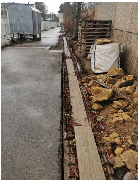
Mise en place de la nouvelle fondation © Ville de Luxembourg – Service Bâtiments
