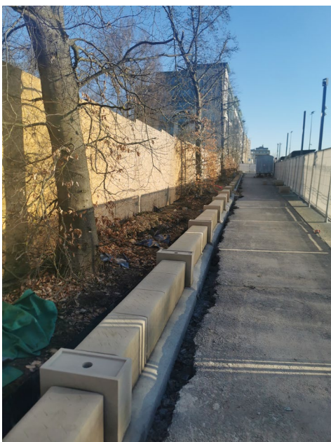
Le nouveau socle est prêt pour accueillir la clôture © Ville de Luxembourg – Service Bâtiments
