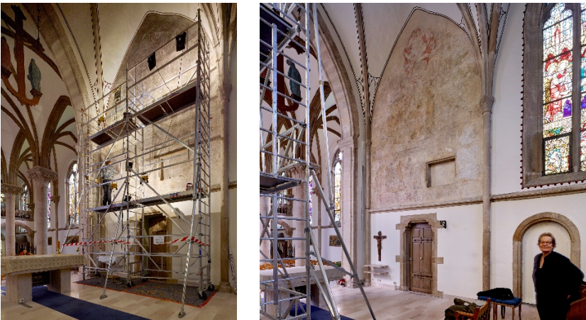
Les travaux en cours et la fin de la restauration, photos : C. Weber
