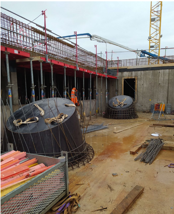
Confection des puits de lumière © Ville de Luxembourg – Service Bâtiments
