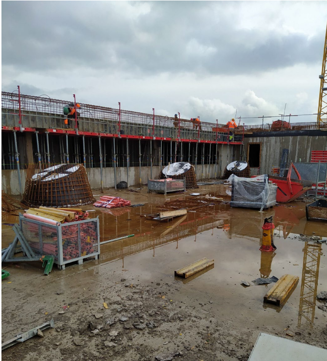
Premier niveau de toiture © Ville de Luxembourg – Service Bâtiments
