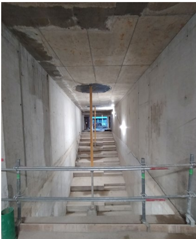
Vue sur l'escalier principal © Ville de Luxembourg – Service Bâtiments
