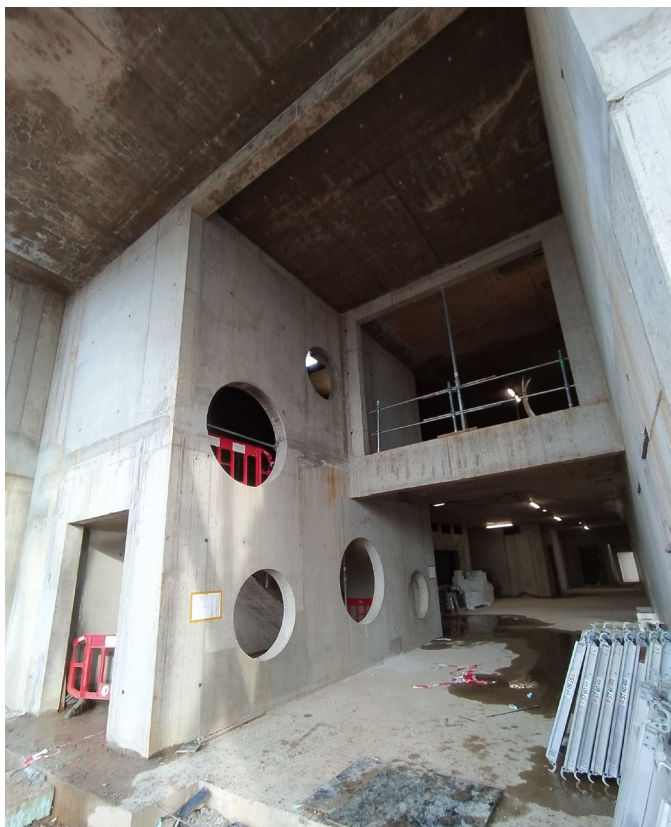
Sas de l'entrée principale © Ville de Luxembourg – Service Bâtiments
