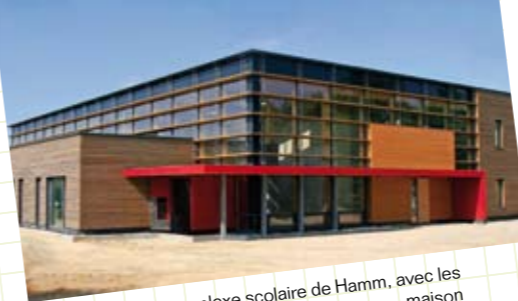
Fertigstellung des Schulkomplexes in Hamm nach Passivhaus-Standard (Energieverbrauch nur 24,4 kWh/m 2 im Jahr)
